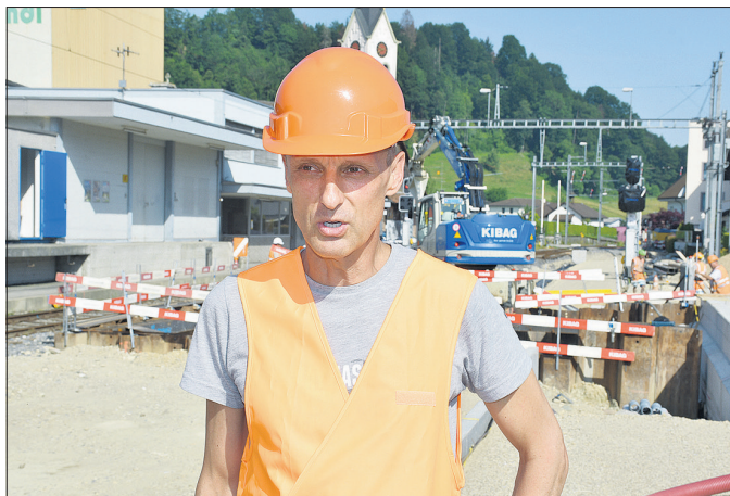
BLS-Projektleiter Paul Hürlimann erklärt die Arbeiten am Bahnhof in Menznau.
