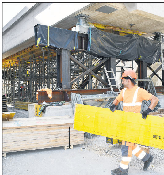
Ab dem 6. Juli wird für drei Wochen zweischichtig gearbeitet, damit die Züge planmässig über die neue Brücke fahren können.
