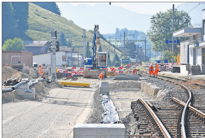
In Menznau entsteht ein neuer Bahnhof mit zwei Gleisanlagen und neuen Gebäuden.
