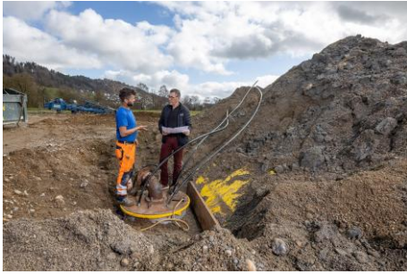
Bild 5: Bau neues Grundwasserpumpwerk Gemeinde Egolzwil (Bild: T. Studhalter)
