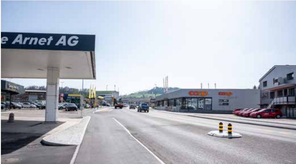
versiegelter Strassenraum mit teilweise Breiten von 50m und mehr (Foto: Atelier Corso)
