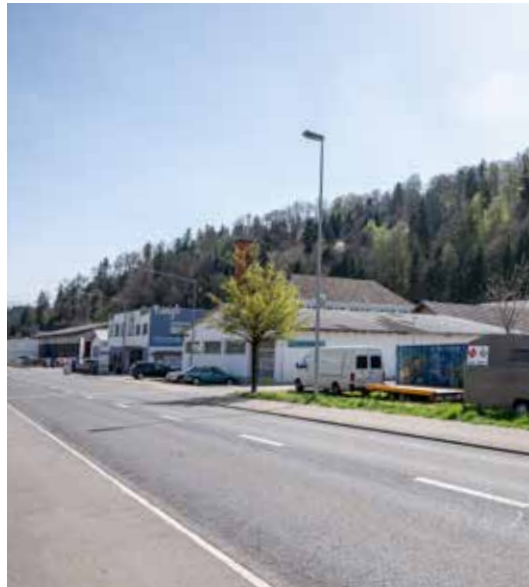
Hoher Erneuerungsbedarf auf der Südseite (Bild: Atelier Corso)
