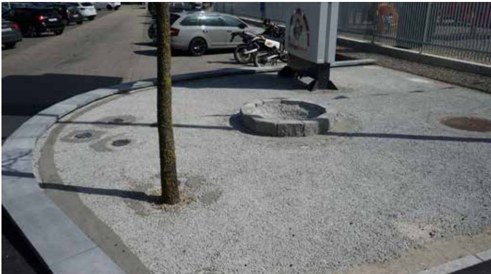
Restflächen werden unterhaltsarm zubetoniert (Foto: Bryum)
