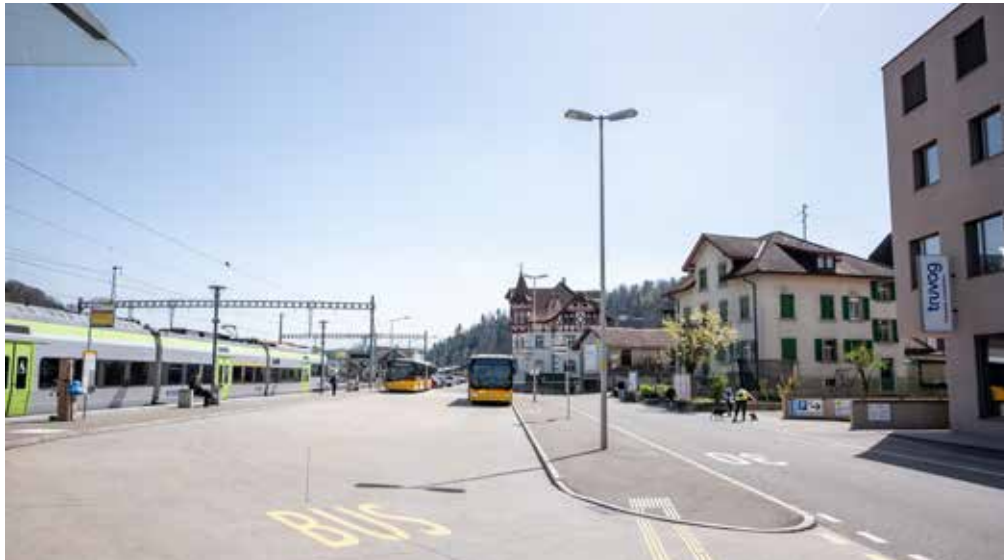
Der Busbahnhof weist noch keine BehiG-konforme Haltekanten auf (Foto: Atelier Corso)
