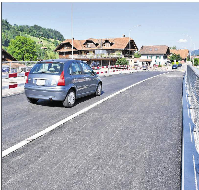
Die Hauptarbeiten an der neuen Rümli-Brücke sind fertig.
