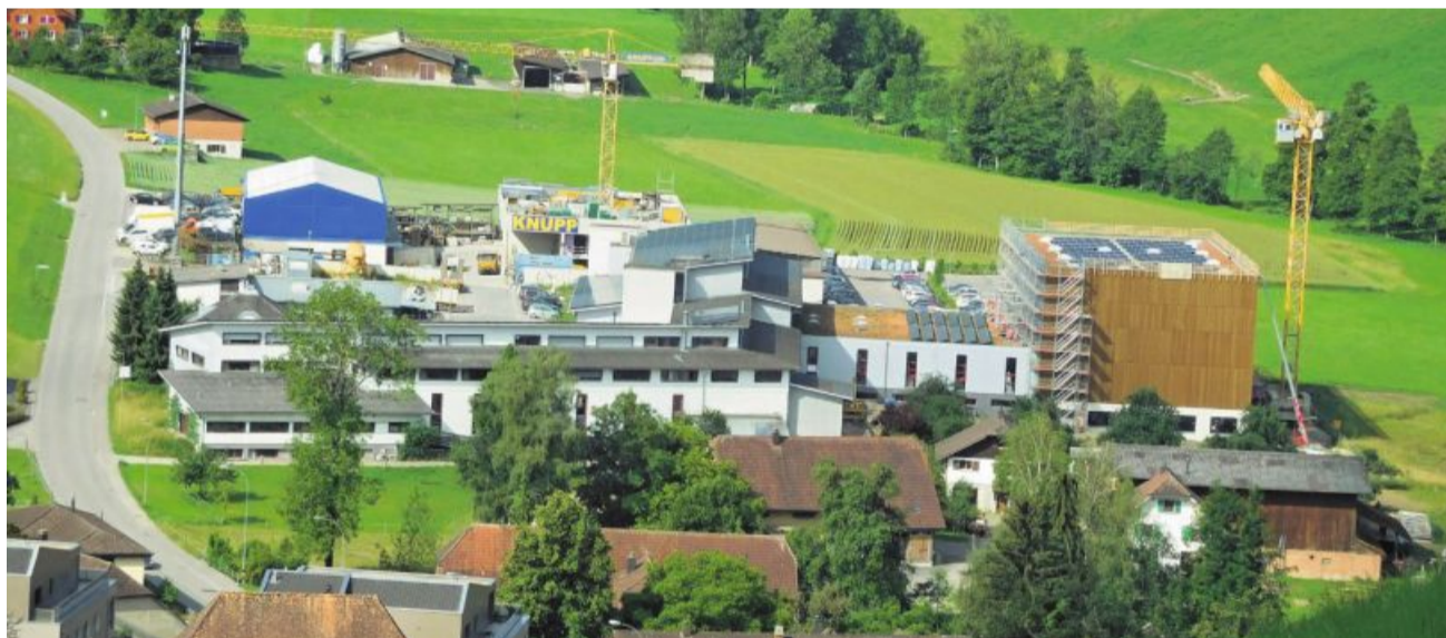
Die neue Holzbaukonstruktion (auf dem Bild rechts aussen) bietet Platz für die Produktion und das Lager. Foto zvg
