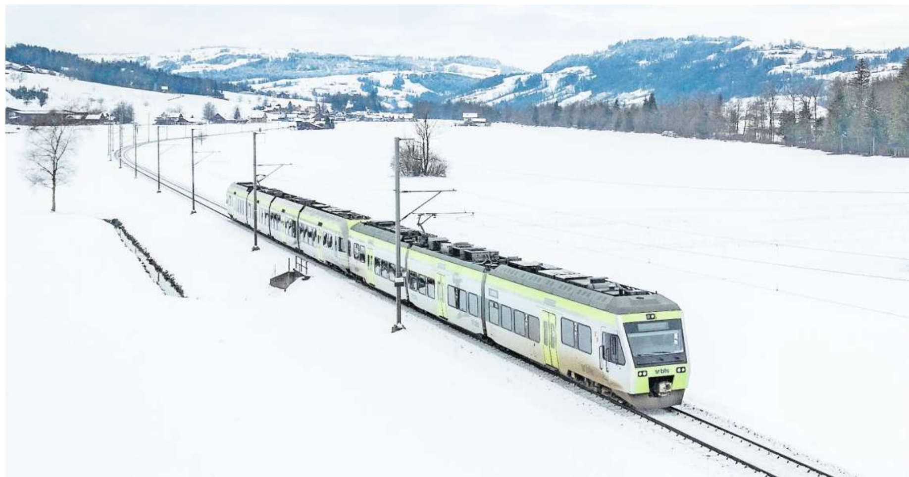
Die Zugstrecke zwischen Littau und Malters soll ein zweites Gleis erhalten.
